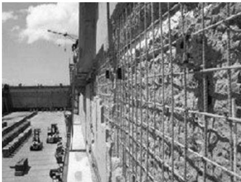
Рисунок 8.11 – Сетка из АНК под покрытие стены крепления котлована
