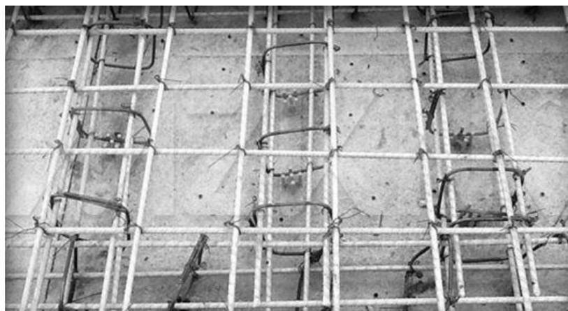
Рисунок 4.3 – Объемный каркас из АНК\*
