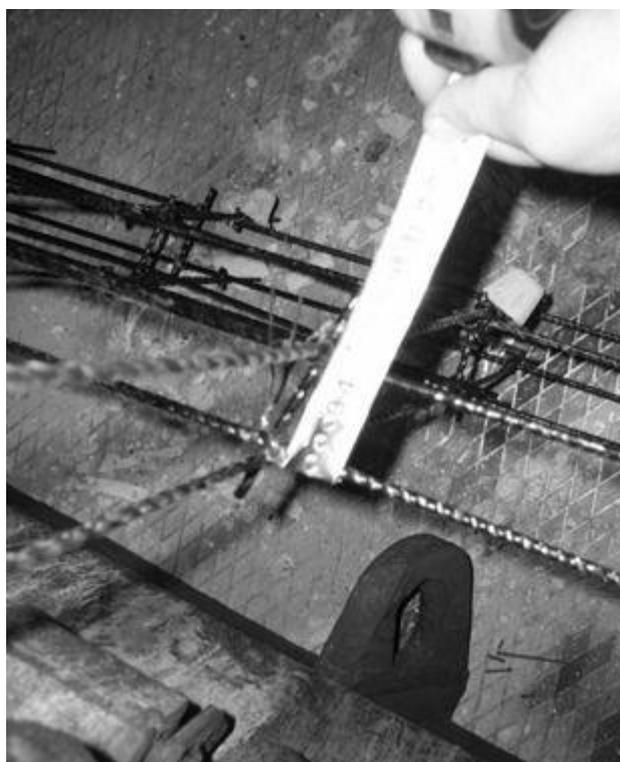
Рисунок 6.4 – Фрагменты арматурных каркасов из базальтопластиковых стержней, уложенных в опалубочную форму дорожной плиты с контролем их геометрических параметров
