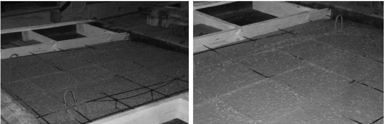
Рисунок 6.2 – Общий вид опалубочных форм с бетонной смесью на этапе изготовления дорожных плит с АНК-Б
