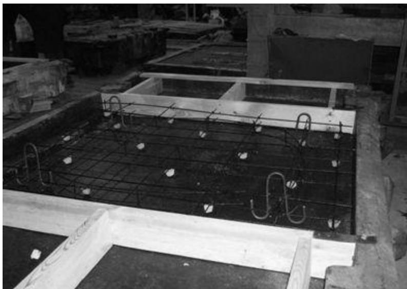
Рисунок 6.3 – Общий вид арматурных каркасов (сеток), уложенных в опалубочную форму опытного образца дорожной плиты
