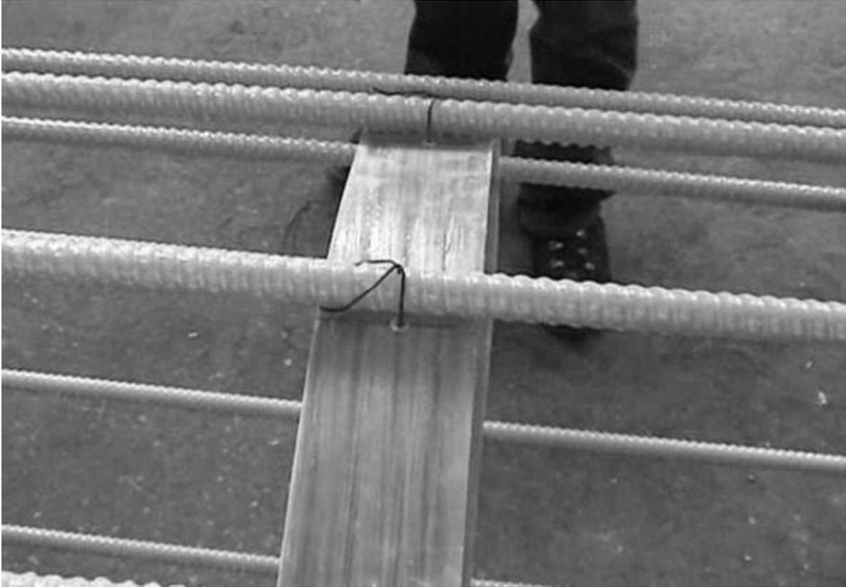
Рисунок 8.32 – Деталь крепления рабочего стержня АНК-С к кольцу жесткости\*
